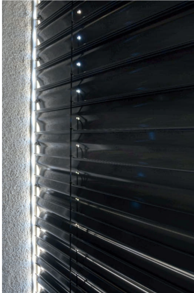
Bild 4. Zulässiger Streulichteinfall über die seitliche Führung
